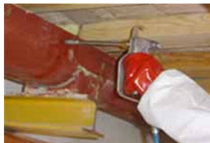
Inyección en viga atacada
